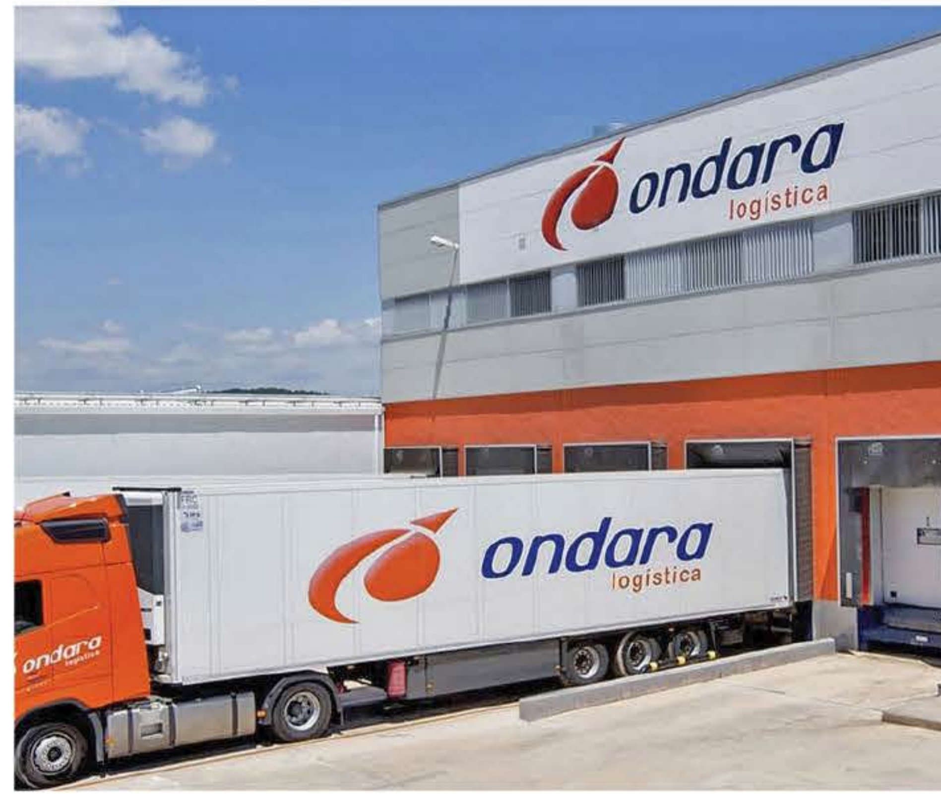
ONDARA LOGISTICA. Lleida, Spain
